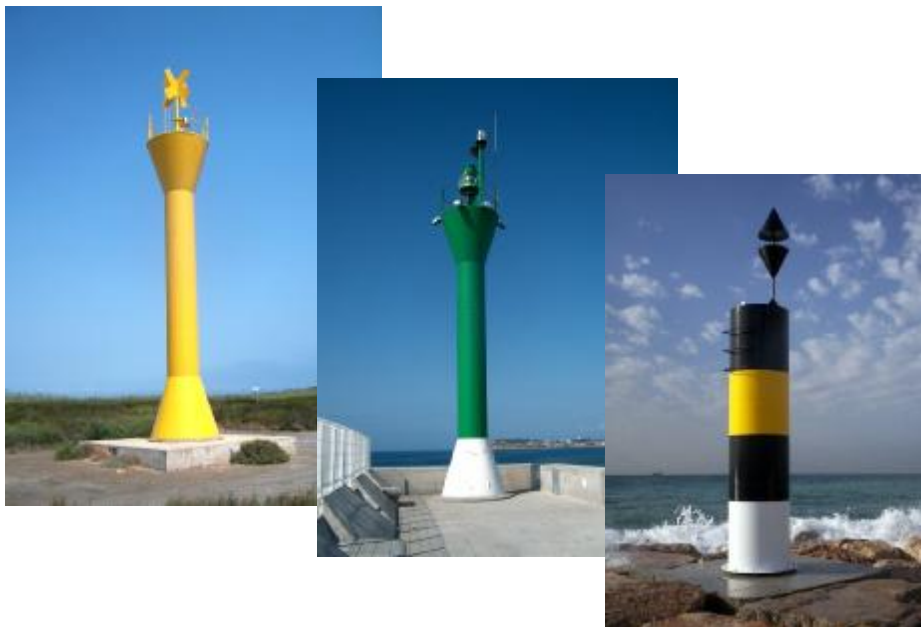
Torres y estructuras de acero inoxidable AISI-316. De izq. a der. baliza del Margen Norte del río Ebro, faro del extremo del Dique de abrigo del Puerto de Tarragona y baliza del espigón norte de la playa de la Pineda (Tarragona). A pesar del ambiente marino y las condiciones meteorológicas, no se advierte ningún deterioro respecto a la fecha de instalación.
