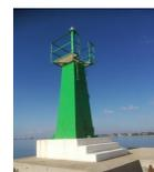
28351 En el Extr. del martillo del dique de levante 40° 48.472'N GpD(2)V 7s 4 3 Poste metálico verde. L0,5 Oc1,5 L0,5 Oc4,5
