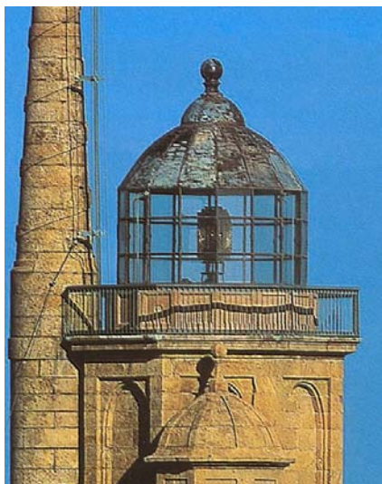
Linterna poligonal de 16 lados
