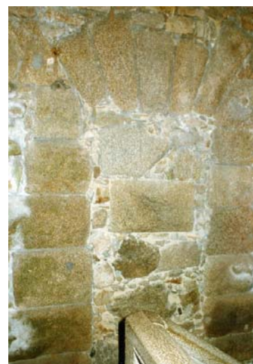
En la estructura interior de la Torre de Hércules se aprecian con claridad los antiguos umbrales de las puertas y las ventanas, parte de ellas condenadas por Giannini
