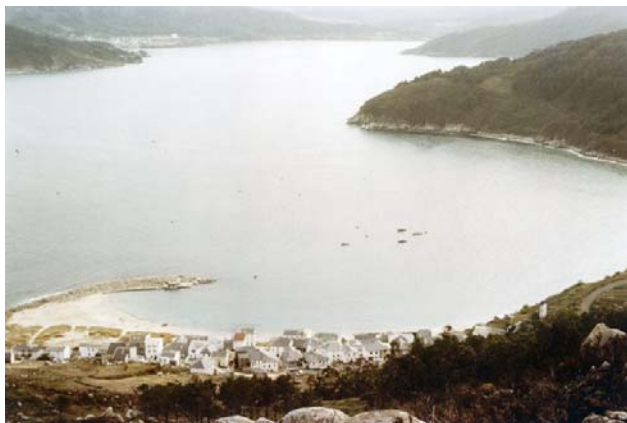
El Puerto de Estaca de Bares (La Coruña) conserva restos de la escollera fenicia
