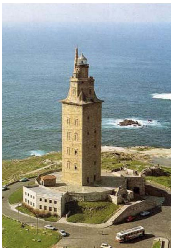
Vista aérea donde se pueden apreciar las demolidas viviendas de los torreros construidas en 1954 (Foto Paisajes Españoles)
