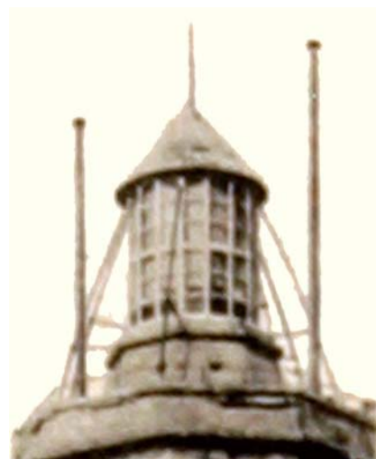
Linterna de cristalera atirantada del Faro de Portopí anterior al primer Plan de Alumbrado español de 1847
