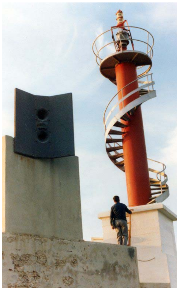
Baliza del que señalizaba el ángulo de la 2ª y 3ª alineación del dique del Oeste del Puerto de Palma, junto a los vibradores de la sirena cuyo control se realiza desde el Faro de Portopí (1980), hoy día sustituida por una marca Cardinal
