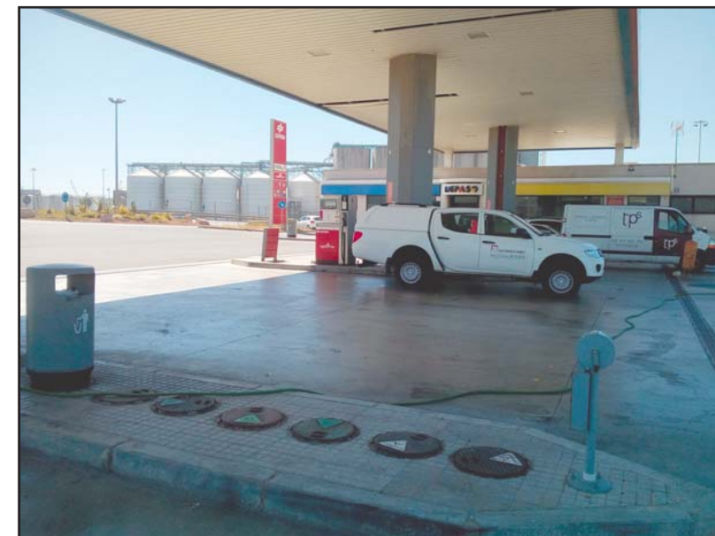
Fotografía 3. Vista de las bocas de carga.
