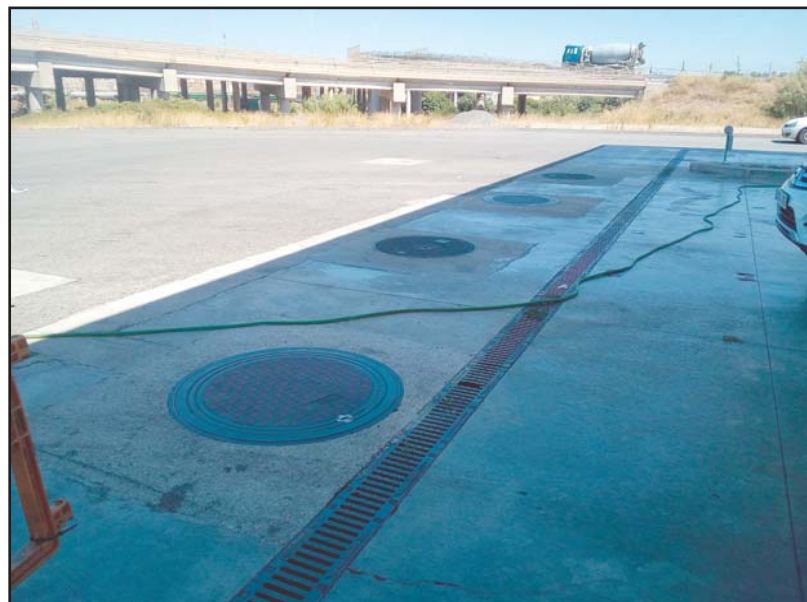
Fotografía 4. Vista de las bocas hombre.
