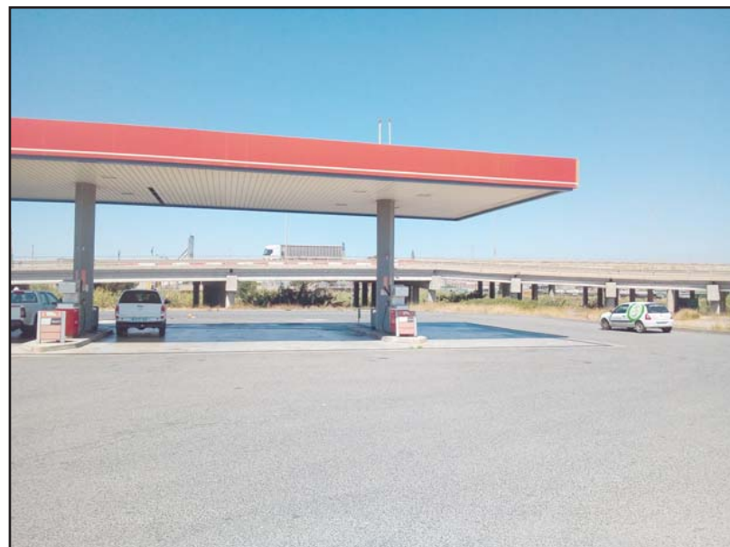
Fotografía 2. Vista general de la parcdela objeto de estudio donde se observa la estación de servicio.
