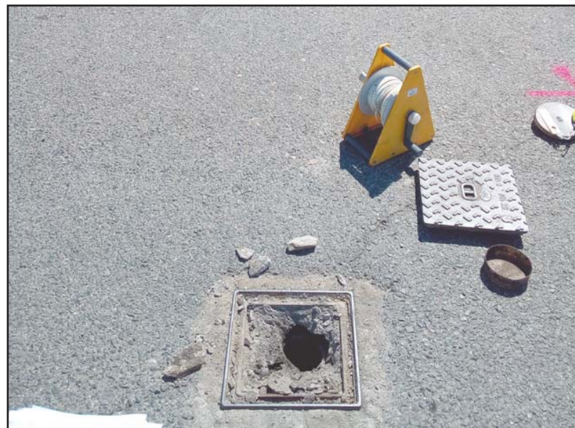
Fotografía 5. Vista del piezómetro S-A existente.
