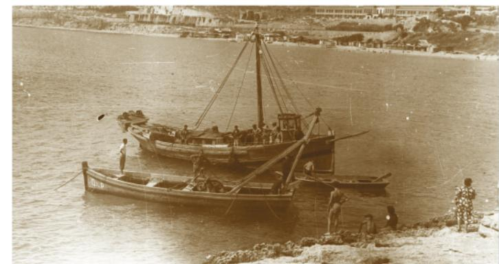
**DESCRIPCIÓN:** Embarcación portuaria destinada a ejercer las funciones de cabria flotante o grúa de mar. Construida con doble cuaderna y sin cubierta, dispone de un seno en proa y otro en popa (cerrados por mamparas) y tres bancos intermedios. No disponía de ningún sistema propio de desplazamiento, sino que era remolcado por otras embarcaciones.
