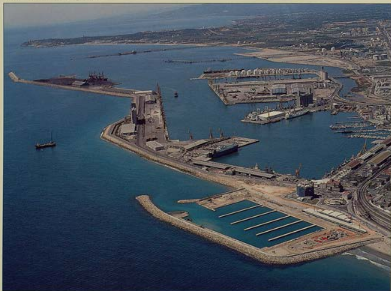
Construcción Puerto Deportivo
