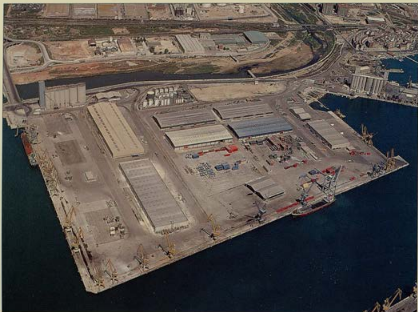
Pavimentación Muelle Castilla
