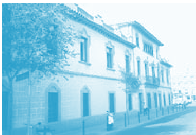
Archivo Central del Puerto de Tarragona
