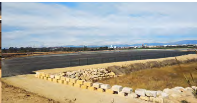
Obras de asfaltado de la ZAL
