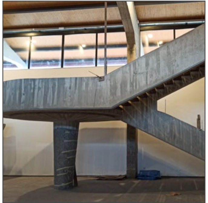
OBRES AL MUSEU DEL PORT
