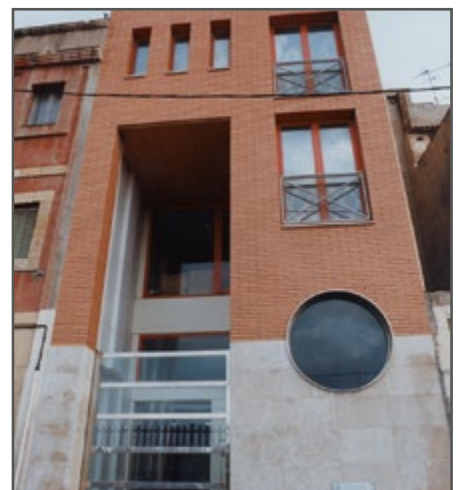
DIPÒSITS DE L'ARXIU DEL PORT DE TARRAGONA
