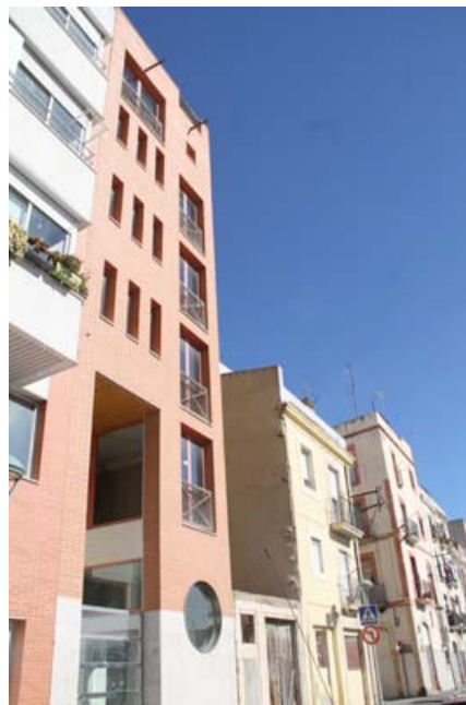
Fons d'Art del Port de Tarragona al carrer del Mar
