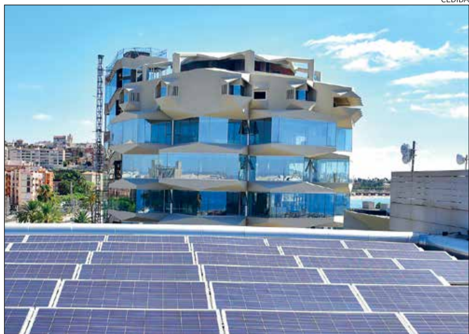
Els treballs han permès adaptar l'edifici a les noves exigències i al Pla de Sostenibilitat del Port.
