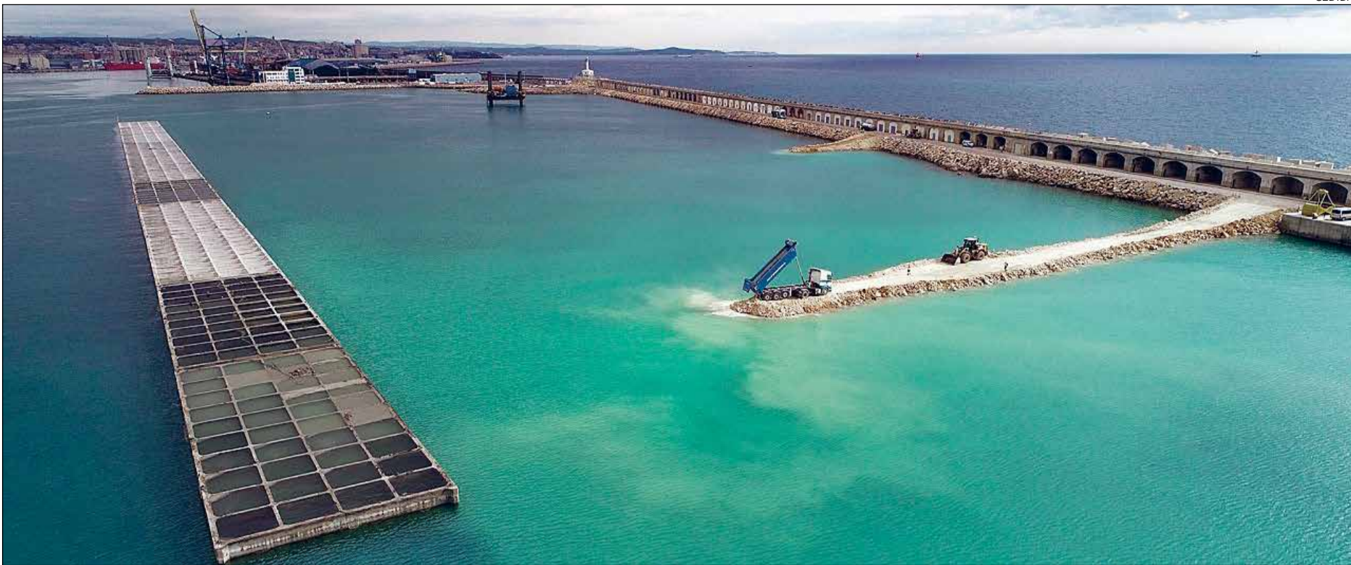
Vista aèria de les obres de construcció del moll a finals d'octubre, amb els onze caixons col·locats i mitjans terrestres treballant en el dic sud del moll, que a hores d'ara ja està connectat als caixons.
