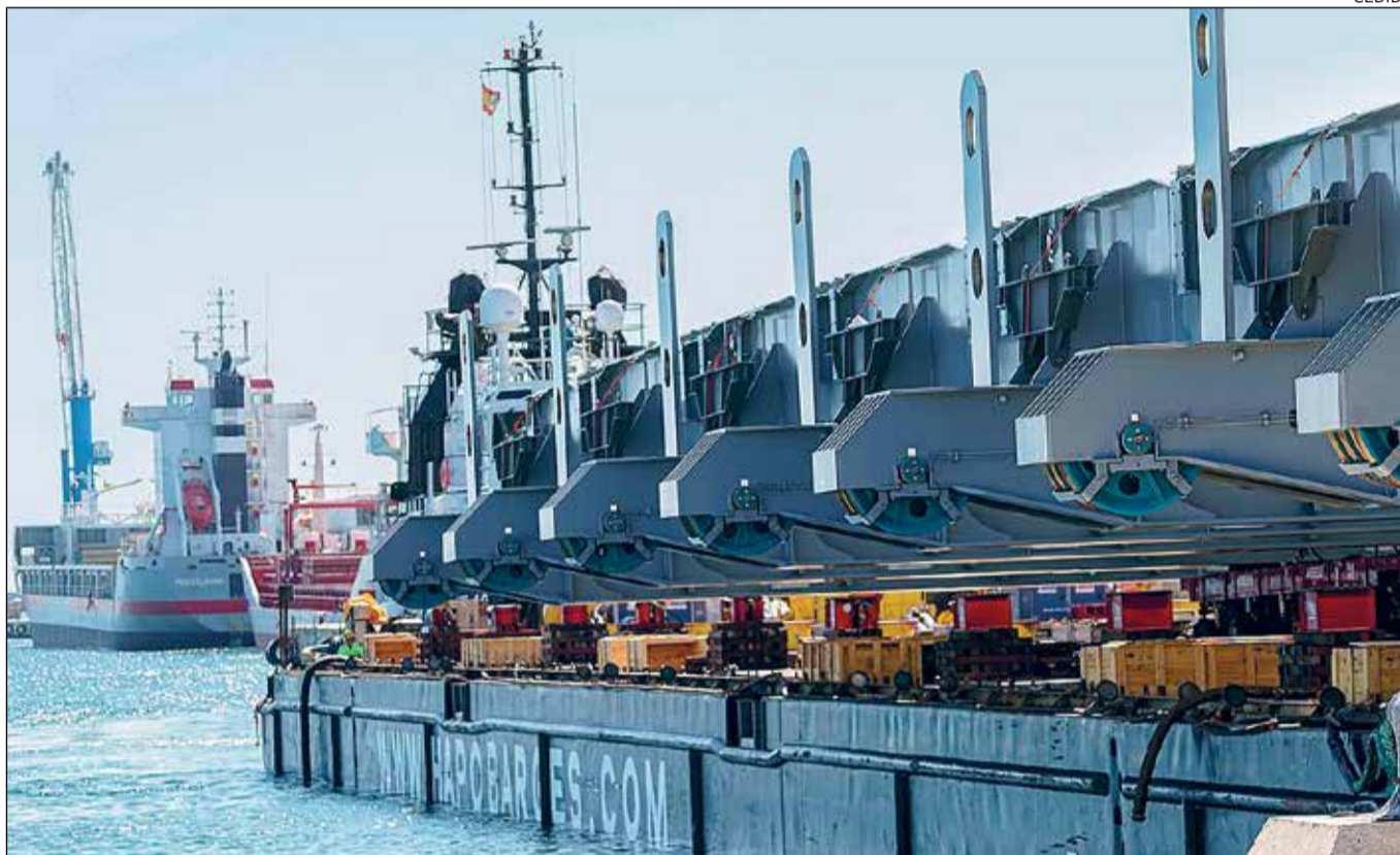
Càrrega a una plataforma flotant de les darreres 9 alineacions del synchrolift que s'ha estat construint al moll de Cantàbria darrerament.
