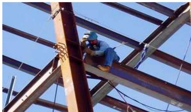
Las **vigas metálicas** son barras que trabajan a flexión. Frente a acciones determinadas, sus fibras inferiores están sometidas a tracción, mientras que las superiores, a compresión.
