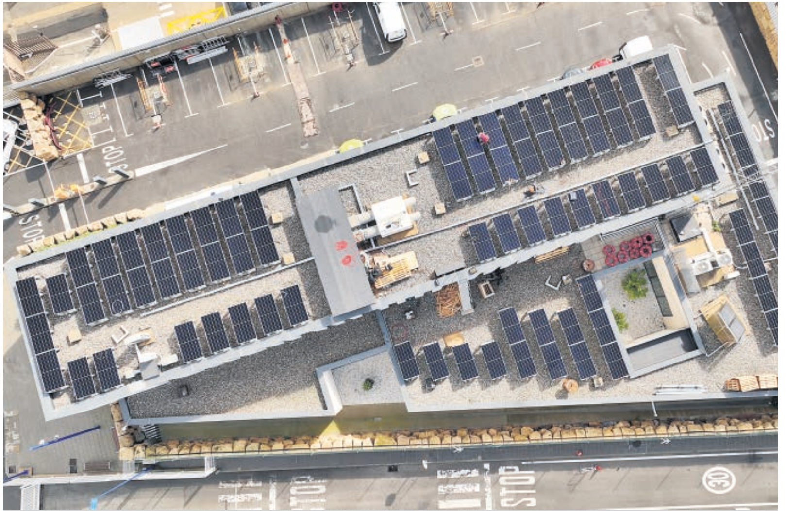
Imatge zenital d'un dels edificis portuaris on ja s'han instal·lat plaques fotovoltaïques per a l'autoconsum. CEDIDA
