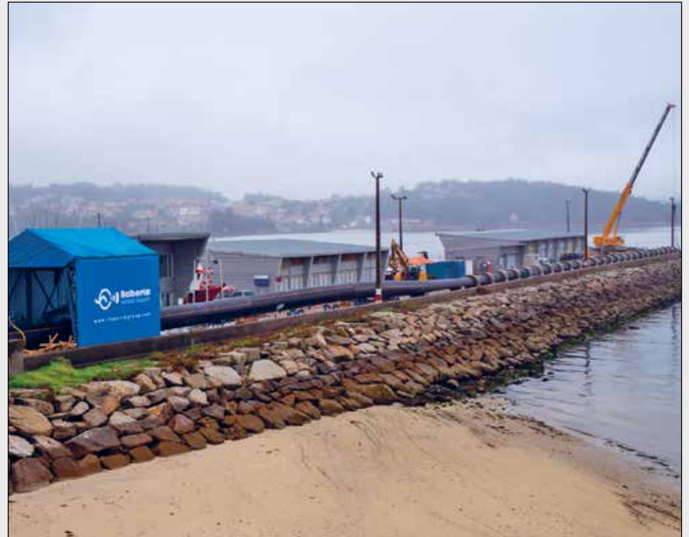
Van instal·lar una carpa al port de Combarro per a poder treballar malgrat el clima gallec.
