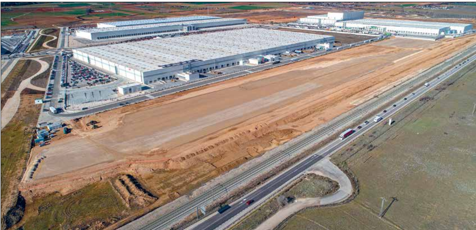
En la primera fase s'ha preparat el terreny per a poder acollir-hi un centre de recepció i distribució de mercaderies via ferrocarril i transport rodat.
