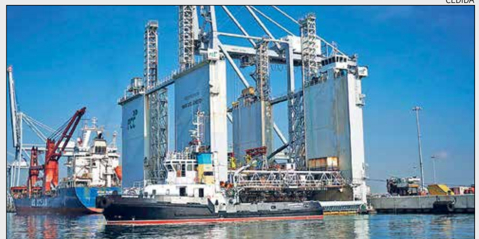
El dic flotant Mar del Aneto ha fabricat els 11 caixons de l'estructura del moll.
