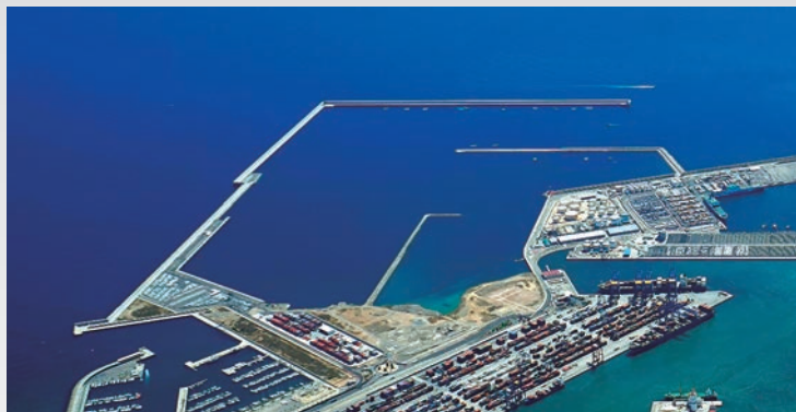
Los aerogeneradores se ubicarán en la Ampliación Norte del puerto de Valencia.
