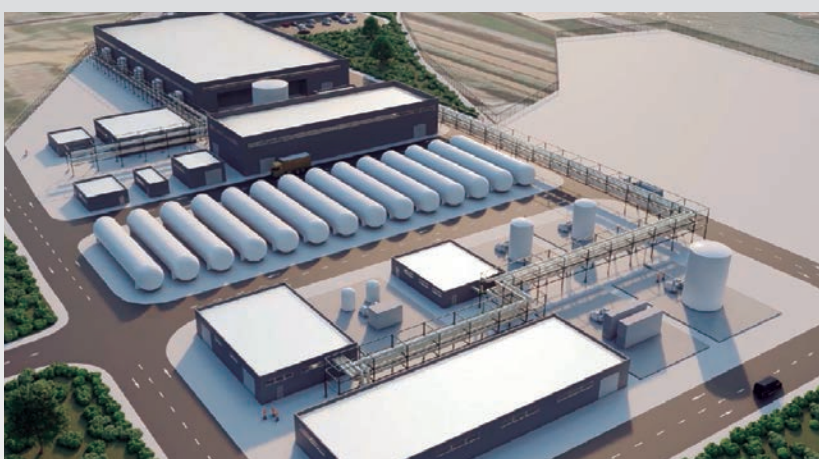
La planta de producción de hidrógeno verde estaría en terrenos portuarios de Palmones.
