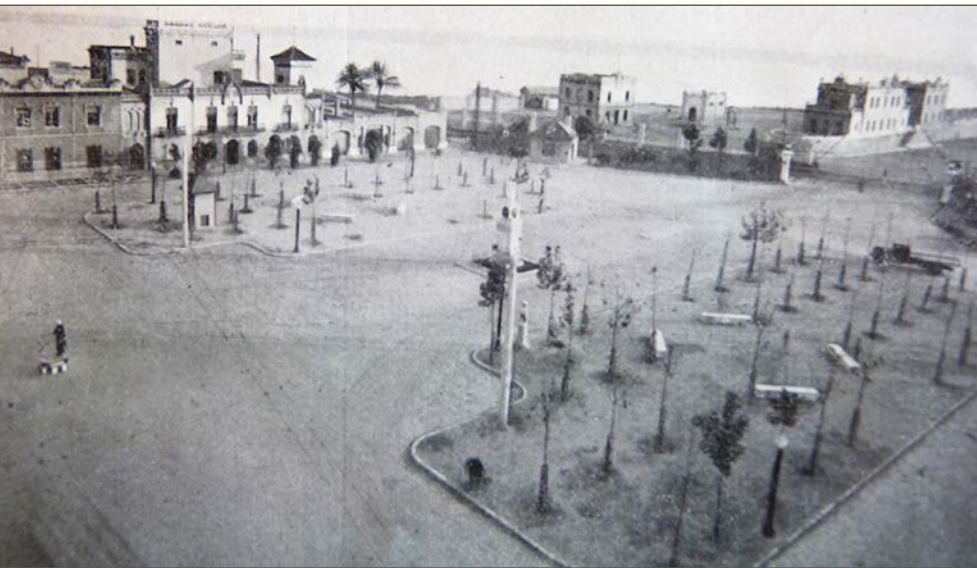
Remodelació de 1953 de Josep M. Monravà. Es veuen els bancs del projecte de 1864 d'Antonio Gras. El podi del guàrdia urbà, el transformador i la bàscula. Els arbres són molt joves, la gasolinera és d'un sol sortidor. (AMT)
