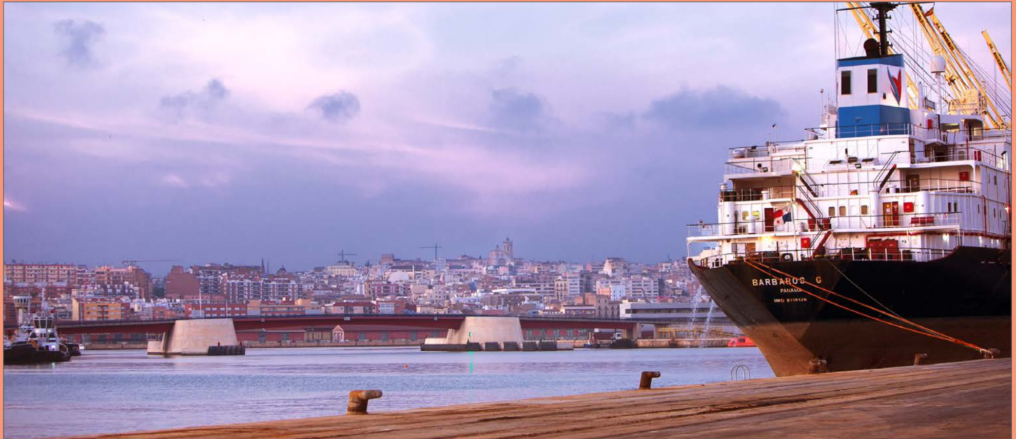
Imatge actual del pont mòbil. Autoritat Portuària de Tarragona. Autor: Mateu Salvat
