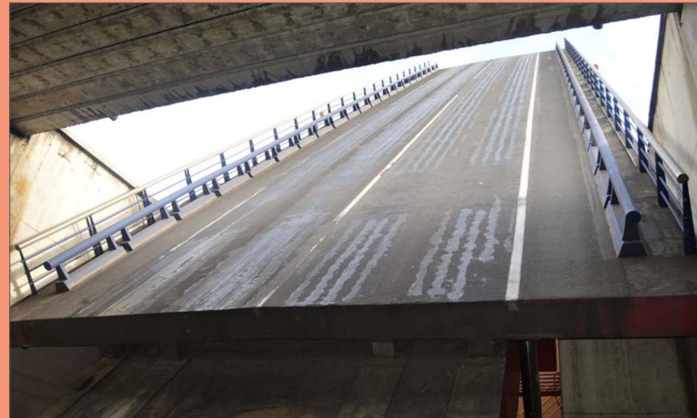
Vista del pont mòbil des del seu interior quan es posa en marxa el mecanisme d'elevació de les dues fulles. Autor: Ricard Lahoz
