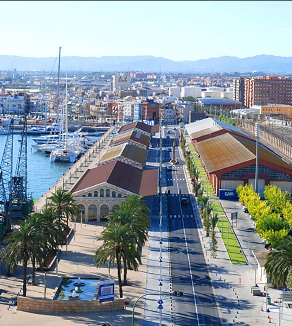
Moll de Costa, l'any 2009, un cop en l'estidala se va reformar. Les grúes històriques encara no s'han traslladat al costat del Refugi 1. Arxiu Port de Tarragona. Autor: Manel Caro
