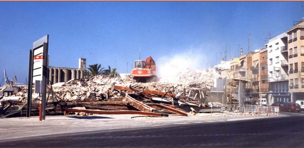
Enderrocament de l'antiga seu del Club Nàutic de Tarragona, l'estiu de 1999. Arxiu del Port de Tarragona. Autor: Manel Caro.
