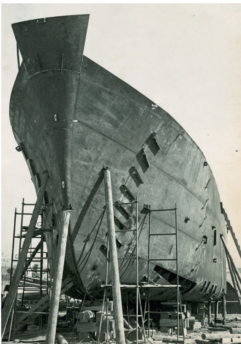
Construcció dels mòduls de la motonau Masiques. Arxiu Josep Maria Garcia Pujol.
