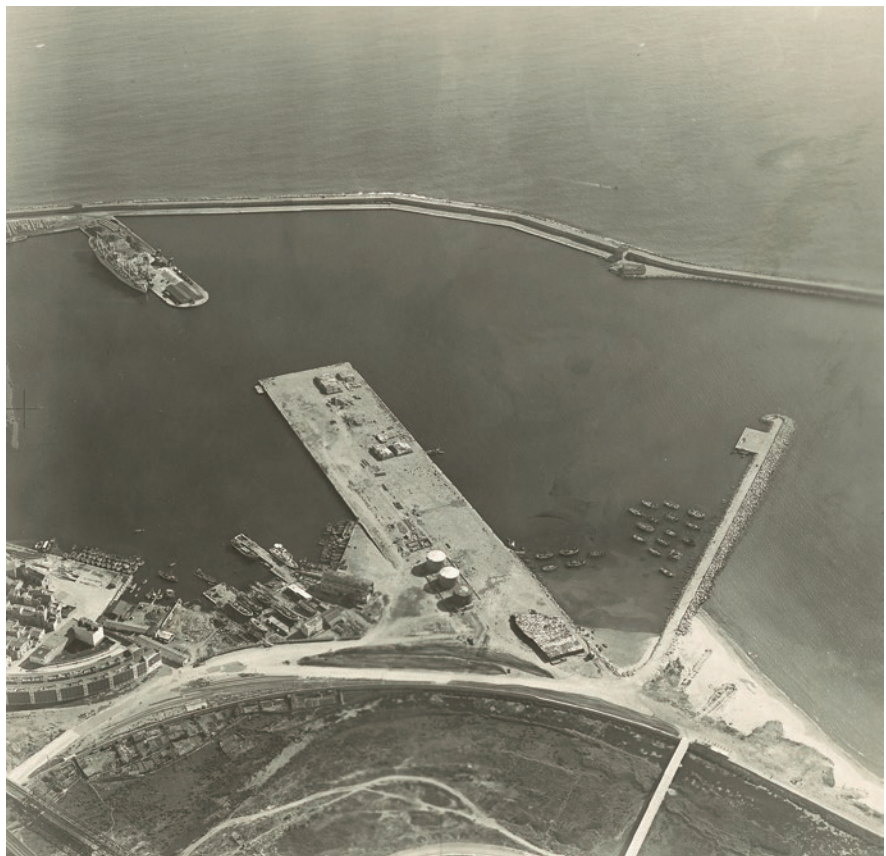
La drassana en un port en plena expansió. Arxiu Port Tarragona.
