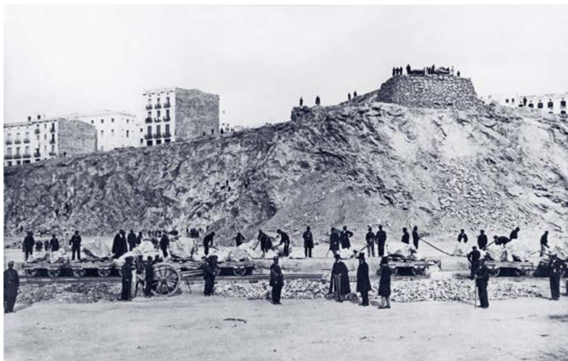
Treballs d'extracció de pedra a la pedrera del carrer de Pons d'Icart, per a les obres del nou port. Es veuen algunes de les vagonetes que feien servir. APT.
