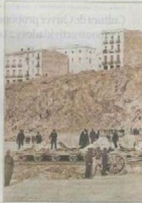
Trabajo de construcción de piedra de la obra de Llevant para las obras del muelle, mediante el sistema de explotación de la fuerza humana.
